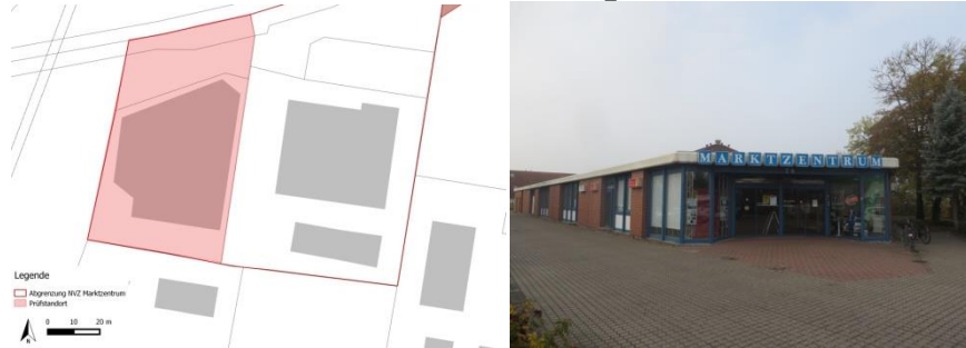
Abb. 73: Prüfstandort Marktzentrum Ronnenberg
